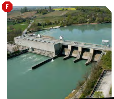
Centrale au fil de l'eau de Verbois (GE)
